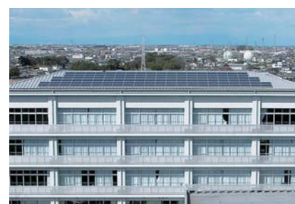
屋根に設置された発電パネル
